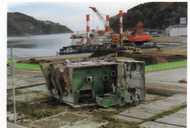
女川町 倒れたままになっている建物
